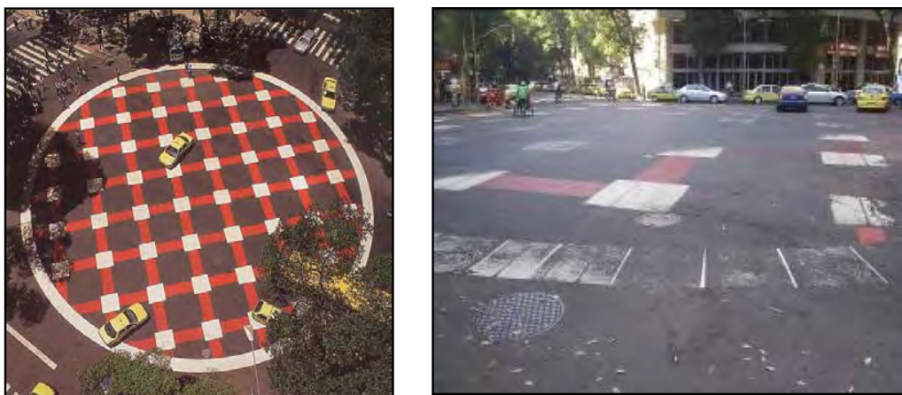
Figuras 138 e 139: Aspecto do rond-point na época da proposta (1994) e o mesmo cruzamento em julho de 2007 reflete a falta de manutenção. Fonte: IPLANRIO e acervo da autora, 2007.
