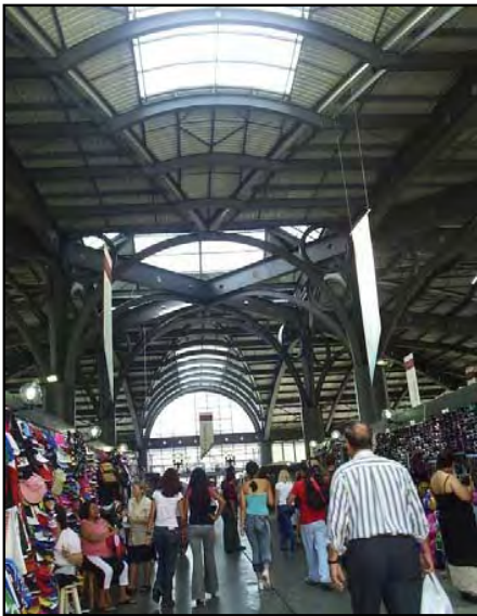
Figura 94: O uso excessivo do vidro na cobertura causa desconforto. Fonte: Acervo da autora, 2006.
