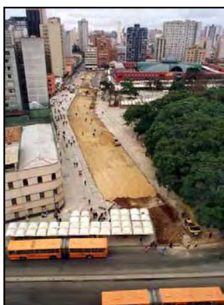
Figura 86: Obras de reabertura da rua. Fonte: www.curitiba.pr.gov.br
