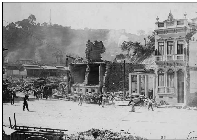
Figura 108: Demolições para a construção da avenida Central, 1904-1905. Fonte: Kok, 2005.
