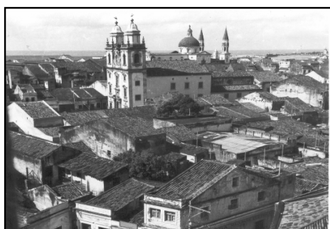
Figura 163: Casario do Bairro de São José demolido para abertura da parte sul da Av.D. Barreto (1968) Fonte: Costa, 2004.
